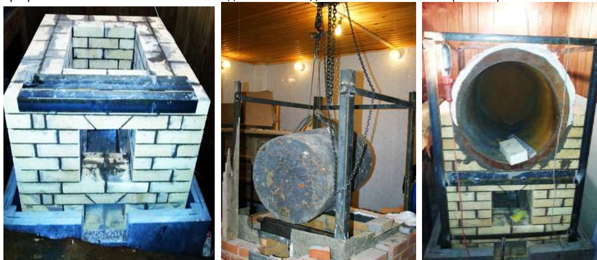
Рис.11. Внутри облицовки уложили кирпичи, на которые установили чугунный стакан от Нур-Марата.
