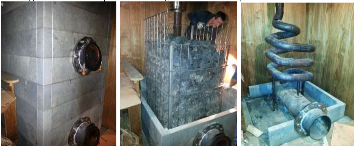
Рис. 10. Исходная печь под переделку. Сняли облицовку. Демонтаж змеевика от финнов.
