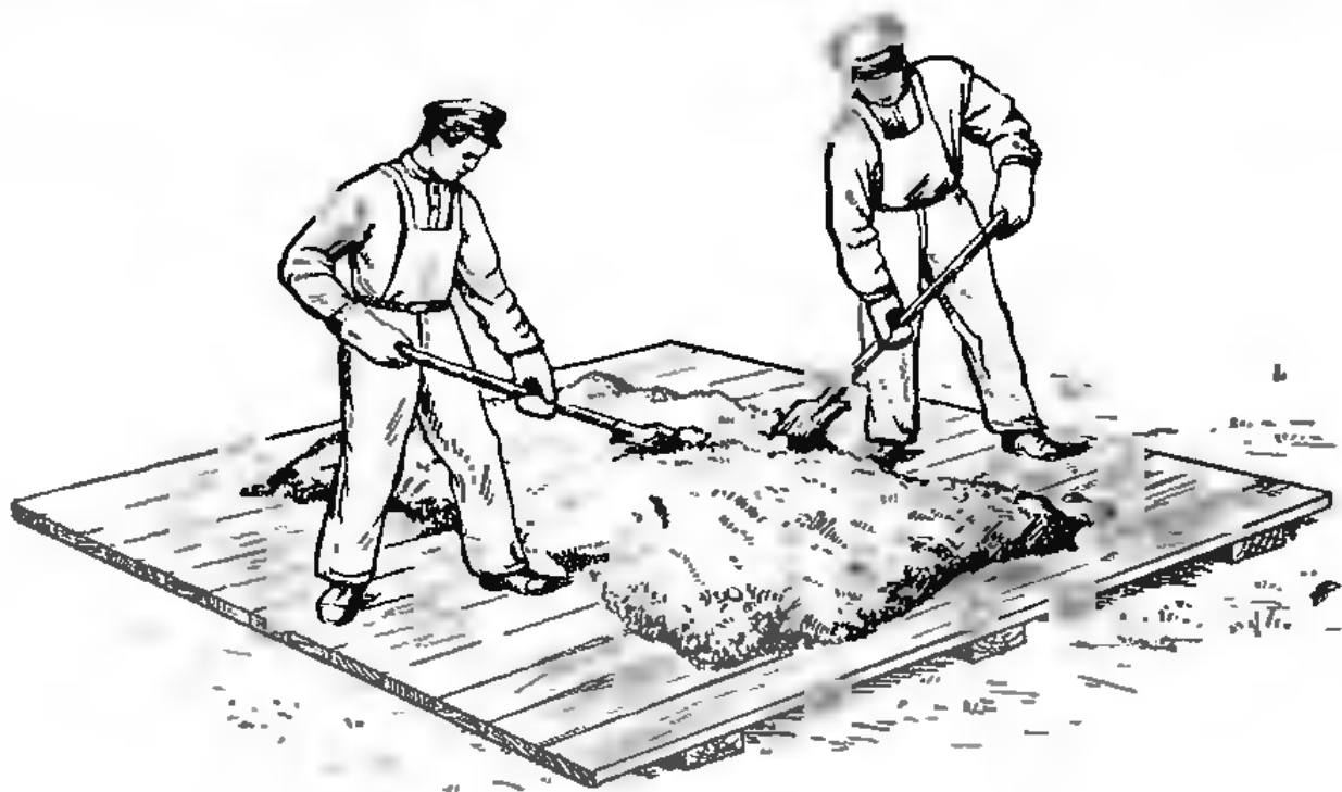
Рис. 5. Приготовление цементного раствора на бойке
