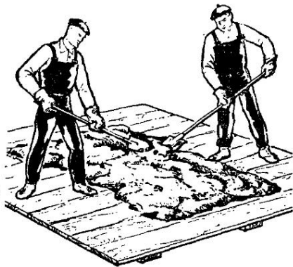
Рис. 56. Приготовление цементного раствора на бойке
