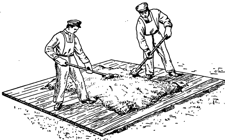
Рис. 18. Приготовление цементного раствора.
