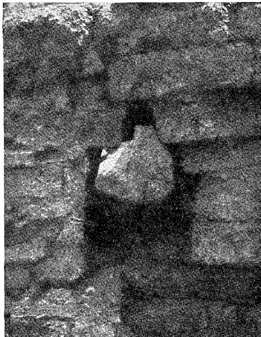
Рис. 8. Канал в подпорном столбе.
