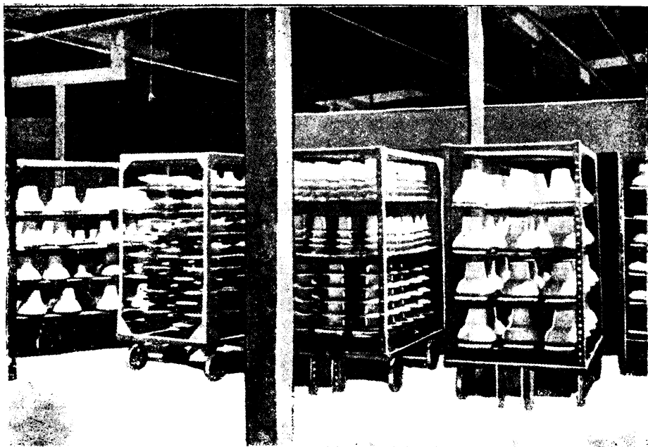
Рис. 221. Четырехколейная туннельная сушилка системы Проктор и Шварц.
