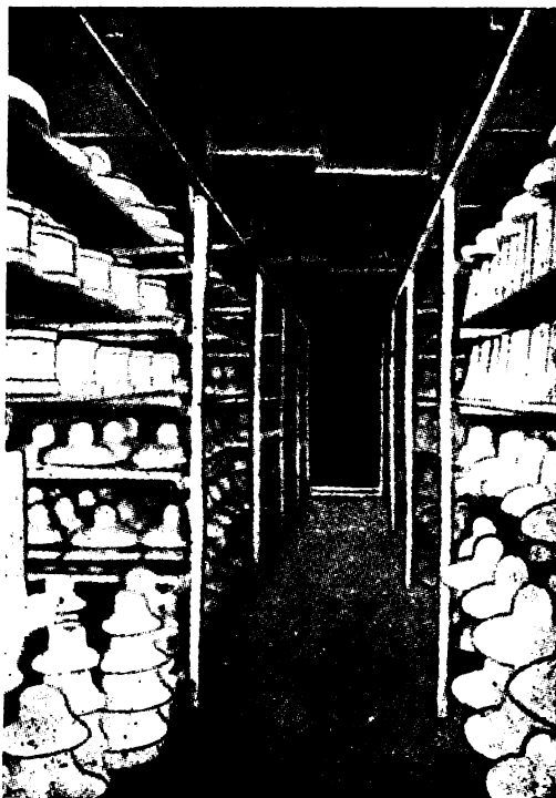
Рис. 215. Размещение электрофарфора в сушилке многократного насыщения.
